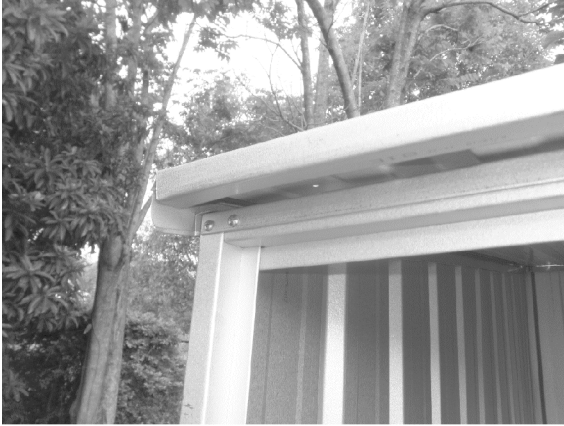
CORNER DOOR JAMB ASSEMBLY
