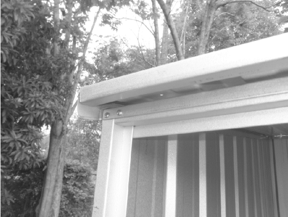
CORNER DOOR JAMB ASSEMBLY
